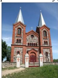
Kościół p.w. św. Trójcy w Plusach; stan obecny
